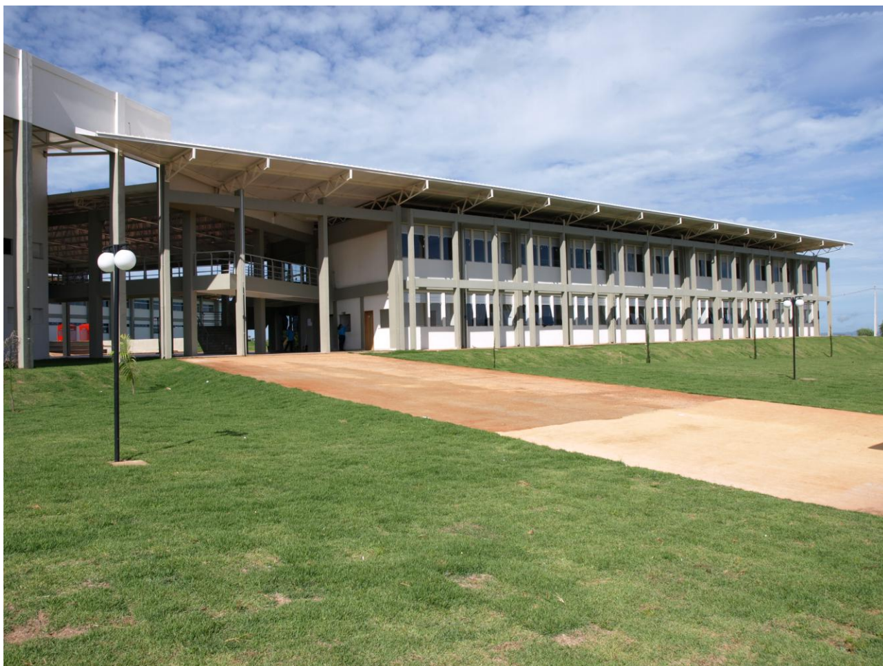
Foto 1 – Fachada do Campus Anápolis.
